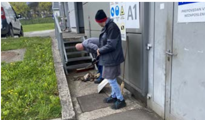
V Vzdrževanju in strojogradnji smo očistili okolico, odstranili odvečni pesek, uredili oglasne deske, terminal in notranjost hale.
