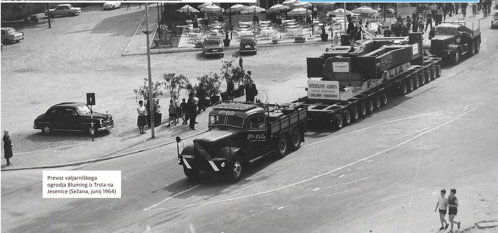
Izgradnja obrata Vroča valjarna na Belškem polju (jeseni leta 1961)
